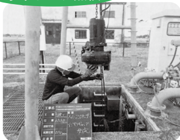
水中ポンプ点検
