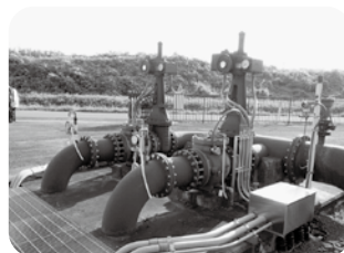
土手前揚水機場 (登米市石越町地内)
