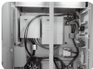
内の目揚水機場 (登米市石越町地内)
