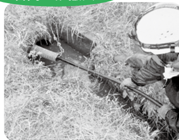
管内土砂撤去
